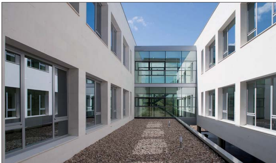
Patio interior del Centro de Salud
